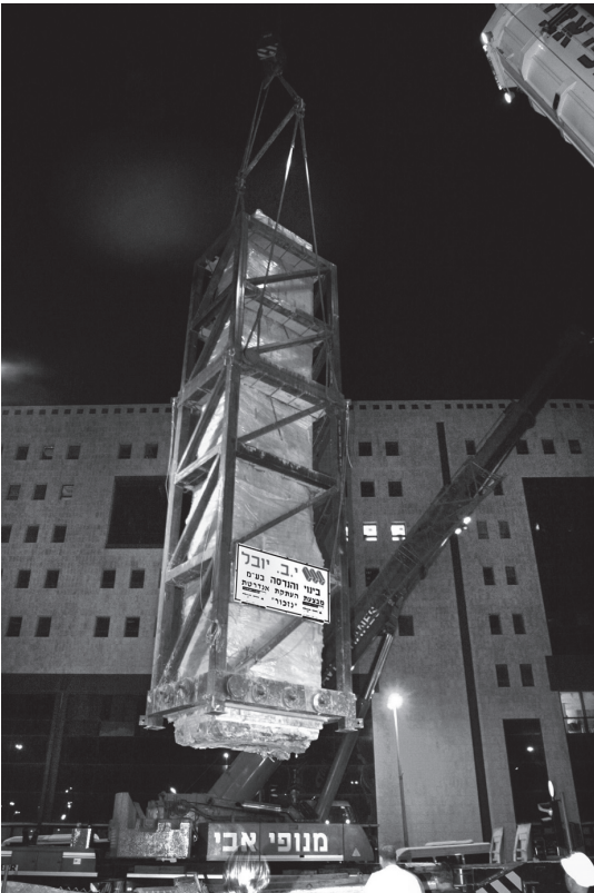
תמונה מס' 7: האנדרטה לאחר ניתוקה ממקומה, מוחזקת בעזרת מנוף.
