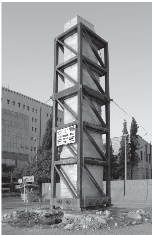
תמונה מס' 5: אנדרטת "נזכור" מול התחנה המרכזית בירושלים, לאחר יציקת בטון אשר חיברה את מסגרות הברזל לעמוד.
