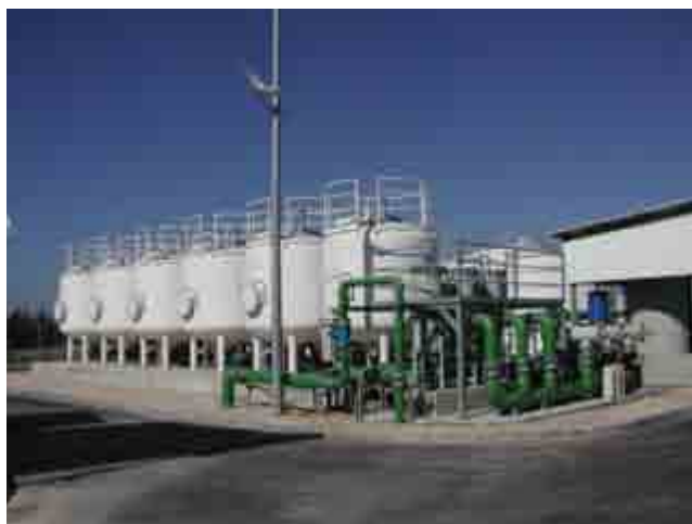
תמונה 5: מסננים במתקן התפלה שמשפרים את איכות המים בכניסה לממברנות ומקטינים את פוטנציאל הזיהום שלהן. (באדיבות חברת מקורות, צילום ששון תירם)
